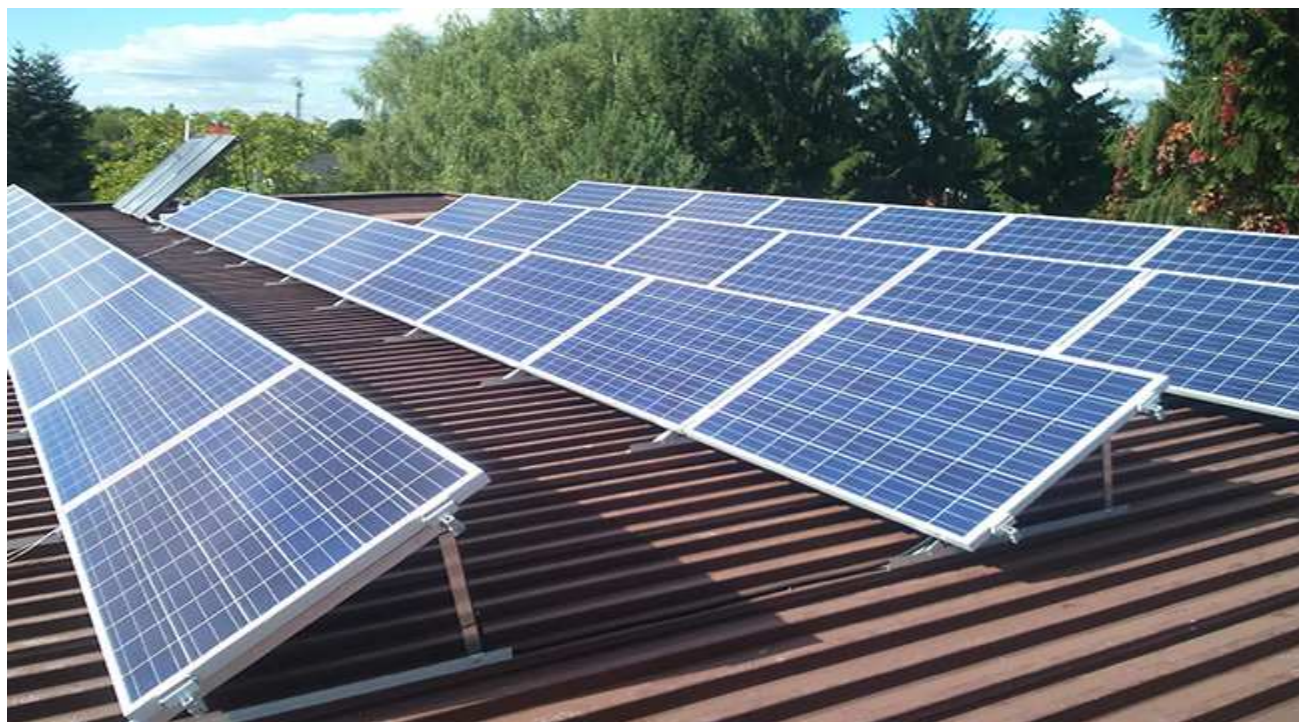
Przykład montażu paneli na dachu płaskim pokrytym blachą trapezową
