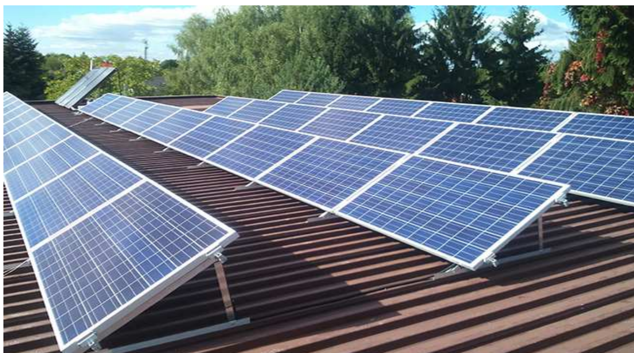
Przykład montażu paneli na dachu płaskim z wykorzystaniem konstrukcji wsporczej balastowanej
